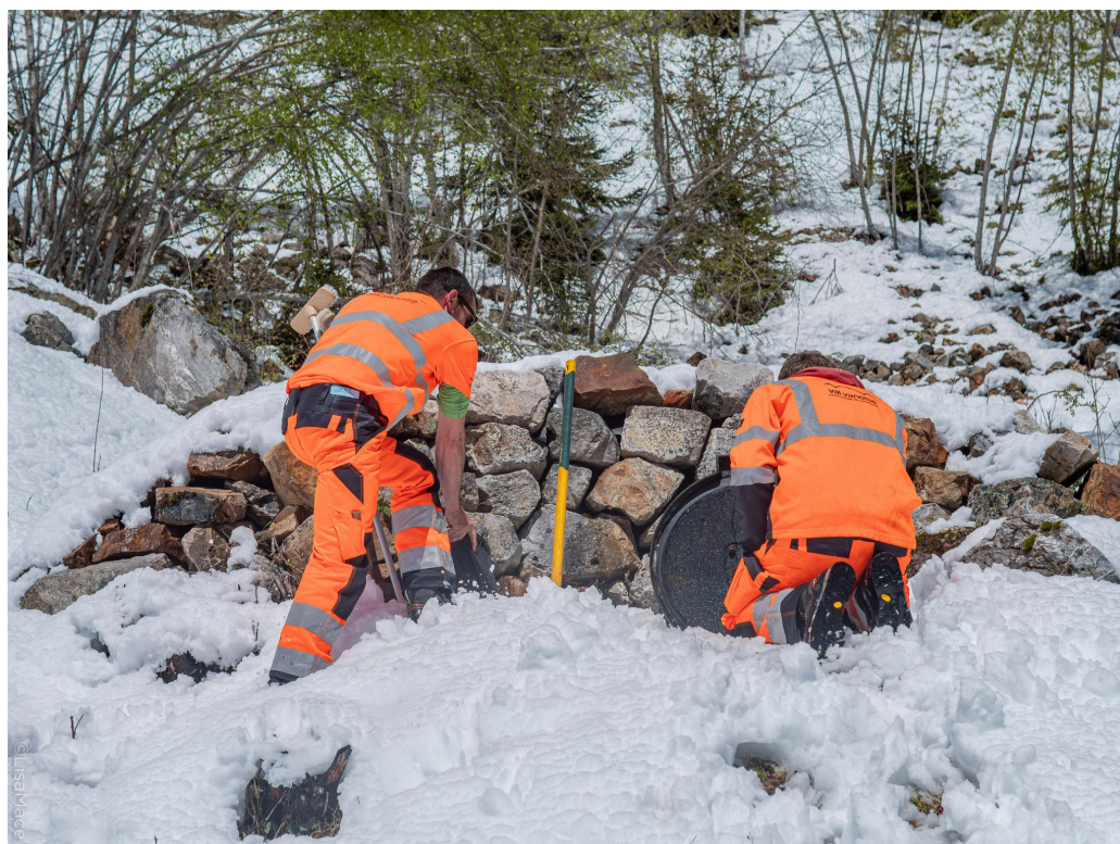
Nettoyage du captage de la Carrière à Bozel
