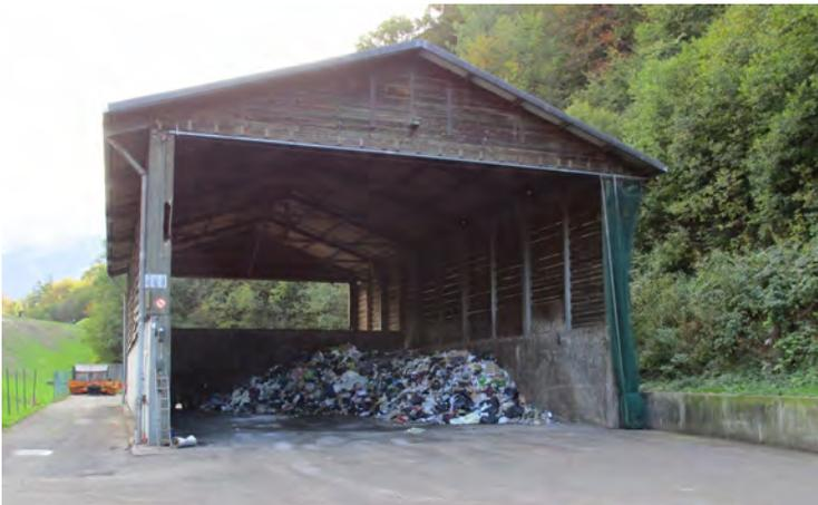
Les quais de transfert permettent de charger et regrouper le contenu des camions de collecte dans des camions de plus grande capacité, avant leur envoi vers les filières appropriées. Cela permet ainsi d'optimiser les transports de nos déchets vers les établissements de traitement.
