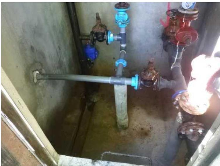
*Intérieur du réservoir, avec l'arrivée de la conduite existante sur la gauche à modifier*
