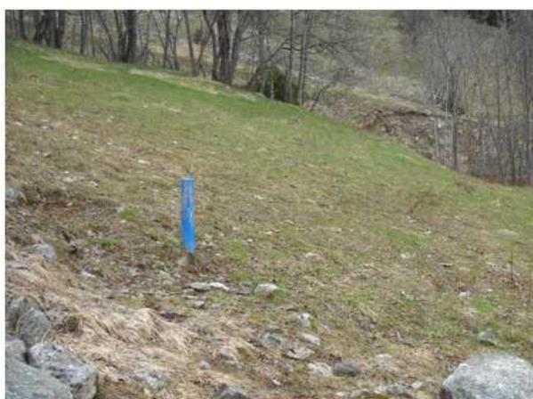
la conduite environ tous les 50 mètres afin de faciliter son repérage. Ces repères pourront être de type tube en PVC bleu 0100 dont l'intérieur est rempli de béton et dépassant de 70 cm environ (voir exemple ci-contre).
