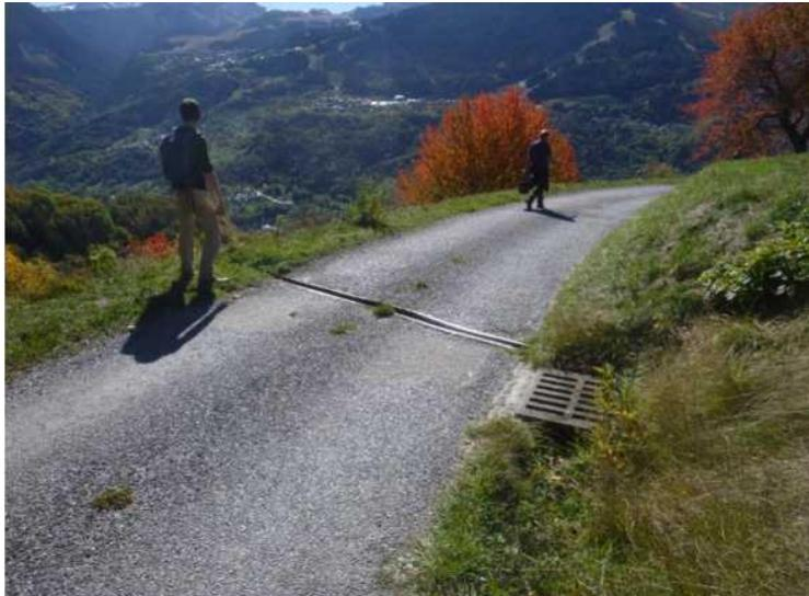
*Route de Moranche, avec une grille + buse en Béton diamètre 400 traversant la route et un renvoi d'eau*
