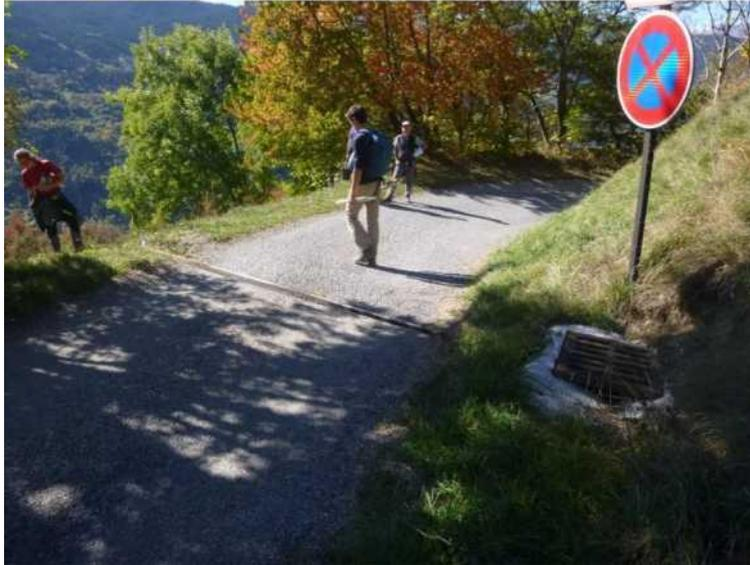
*Route de Moranche, avec une grille + buse en Béton 0400 traversant la route et un renvoi d'eau*
